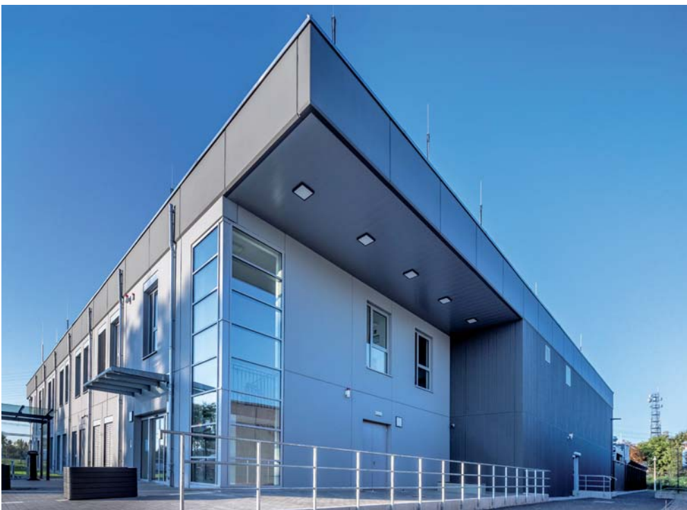
Der neue Internetknotenpunkt in Leipzig wird in den Rechenzentren von PÿUR Business und dem abgebildeten Zentrum von envia TEL betrieben
