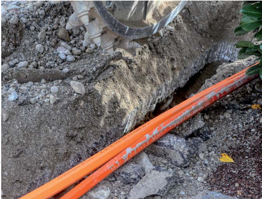
Dass Sachsen laut Breitbandatlas bei der Glasfaserabdeckung an dritter Stelle steht, liegt auch daran, dass frühzeitig im Freistaat Leerrohre verlegt wurden
