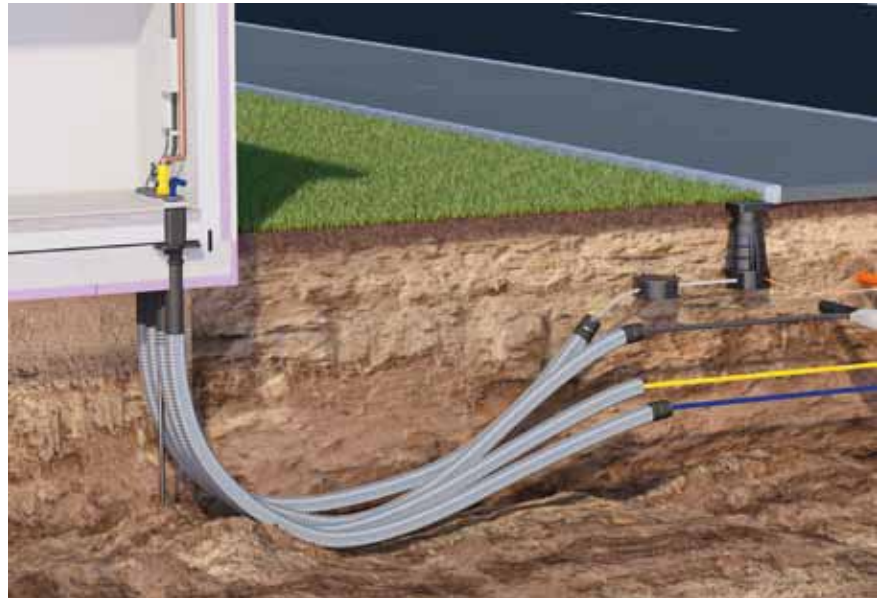
Die eingebaute G-Box. Der Glasfaser-Abschlusspunkt wurde im wasserdichten Gehäuse der G-Box installiert. Erst wenn der Kunde den Anschluss wünscht, wird der Hausanschluss fertig gestellt und das Gebäude mit der G-Box verbunden.
