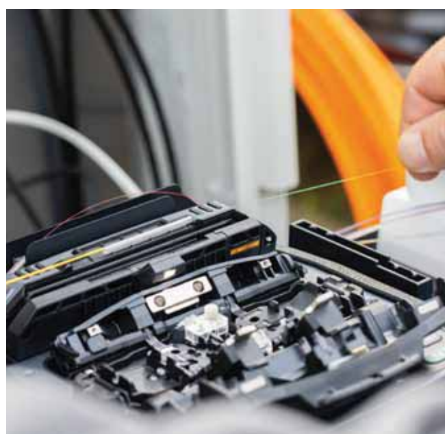
Abbildung 4: Entnahme der verspleißten Fasern
