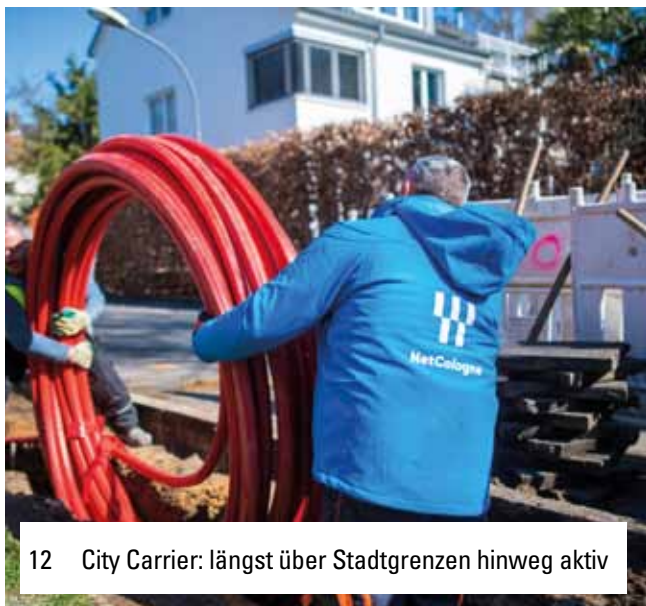
20 Verlegen eines Glasfaser-Hausanschlusses
