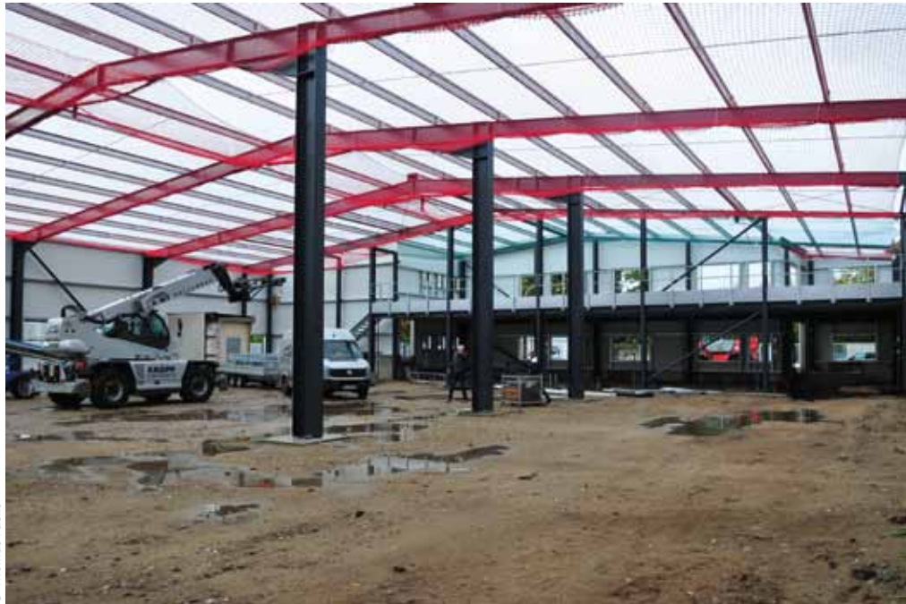
Der Neubau bietet inklusive Hochregallager eine Fläche von über 4000 Quadratmetern
