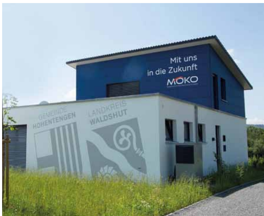
Neues Rechenzentrum des Eigenbetriebes MOKO in Hohentengen
