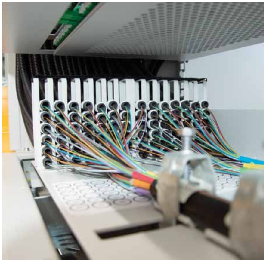
Bündeladereinführung zu den SLITE Patchpanels im CARMA ODF-Rack
